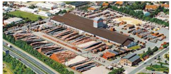
Fabriek Dieburg (Betonpannen)
