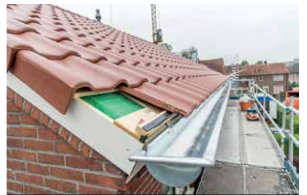
De nieuwe keramische dakpan F-8½ heeft een asymmetrische vorm en een minder sterke golving dan de andere panmodellen van Nelskamp.
