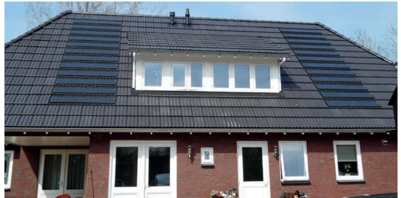
In Rossum zijn twee stroken van twaalf modules aangebracht. Dit zijn 2Power modules voor zowel het opwekken van elektriciteit als het verzorgen van lage temperatuur tapwater.
