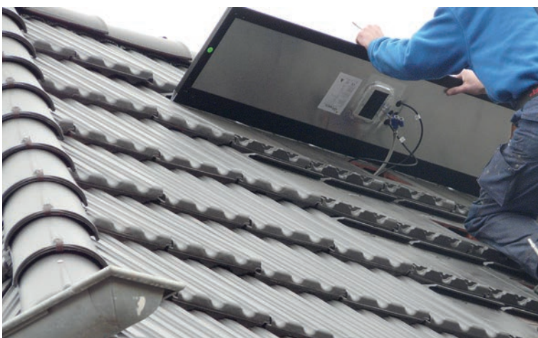
De draagpannen worden altijd van rechts naar links geplaatst met als vierde de pan met de sparing. De modules brengen men van boven naar beneden aan, om te voorkomen dat hierover wordt gelopen.
