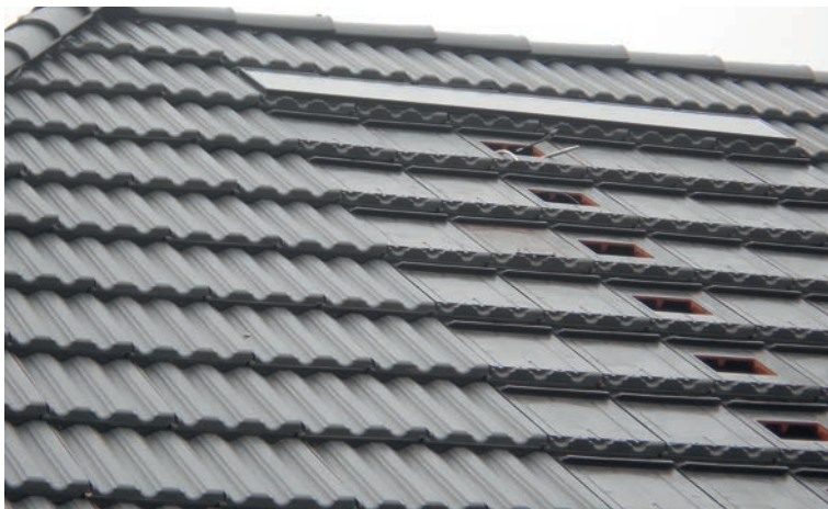
In één van de vlakke MS-5 pannen zit een sparing voor de connector-doos achter op de module. Ook de bekabeling wordt daardoor naar binnen gevoerd.
